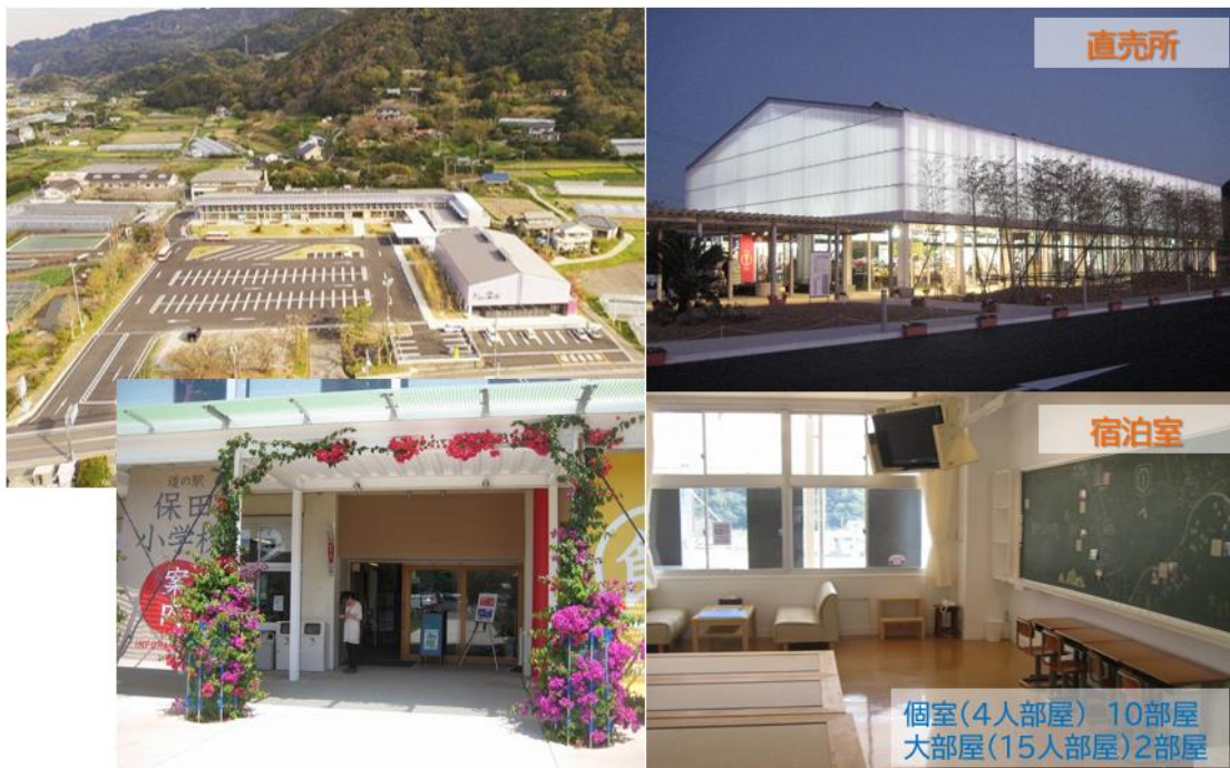
(鋸南町提供資料より)
