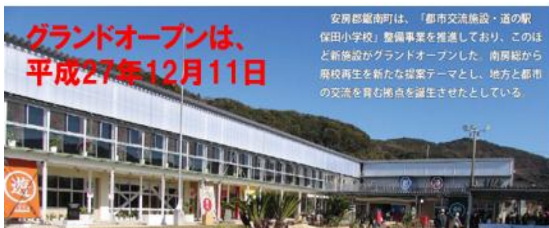
（鋸南町提供資料より）
